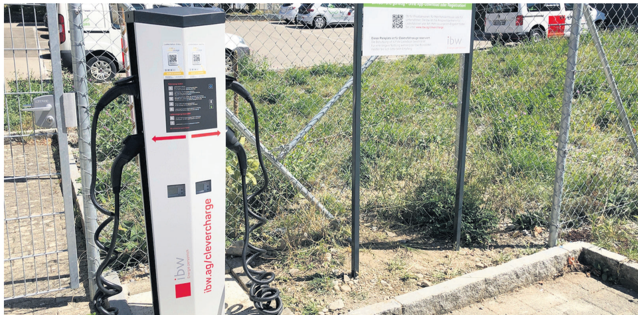
Die neue Ladestation an der Steingasse – selbstverständlich mit Ökostrom betrieben.
