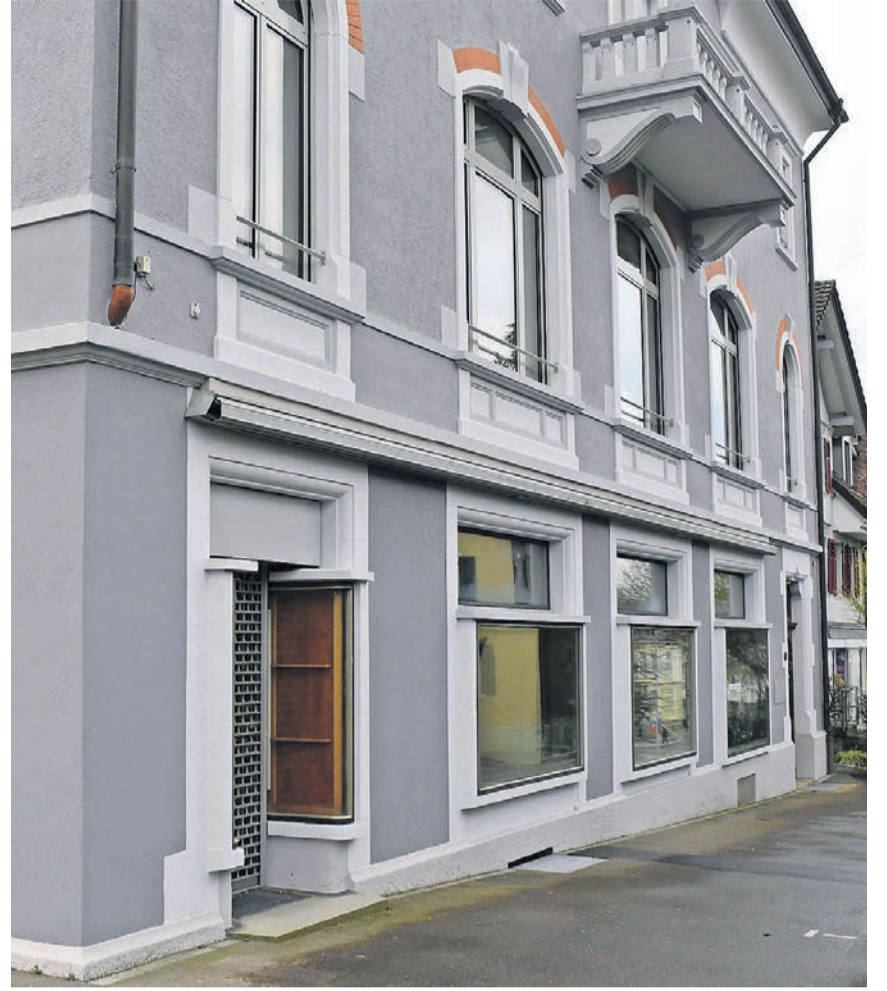
Am Chilegässli 1 im Erdgeschoss des Domherr-Meyer-Hauses: Der Standort des Kafi Hoi.
