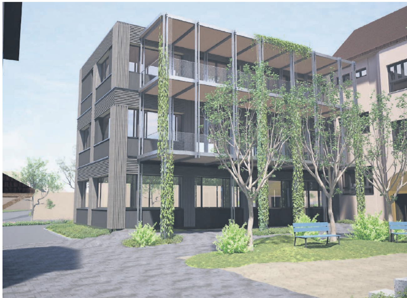
Modernisierung der Integra an der Jurastrasse: Das Modell zeigt den neuen Trakt neben dem Eingang.
